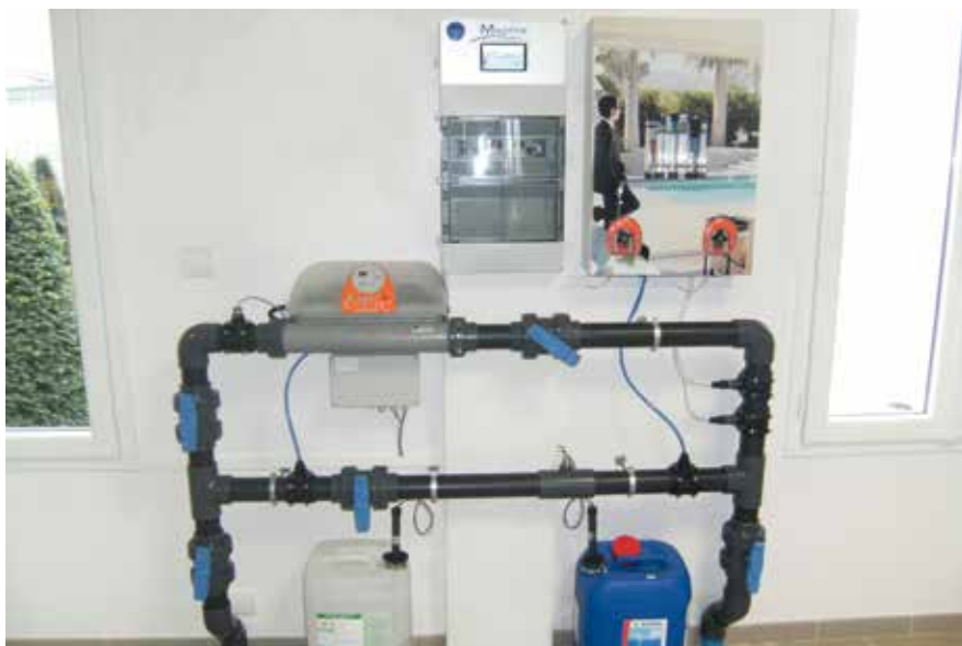
Modello presentato iMAGI Sérénité: collegamento a distanza; riempimento automatico: unità di controllo separata
