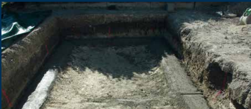
2 - preparazione della platea di fondazione
