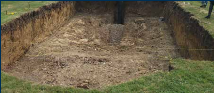
2 - preparazione della platea di fondazione
